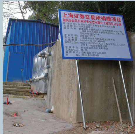
上交所资助安全饮水提升工程项目
